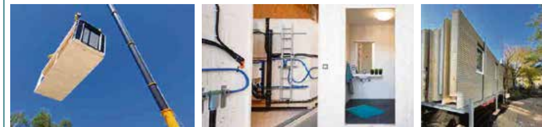
Holzmodulbau Fertigtüder serielle Fassaden
